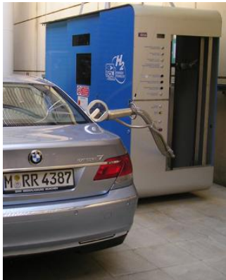
Progetto Bicocca: stazione di rifornimento di H 2 compresso (200 bar) e liquido
