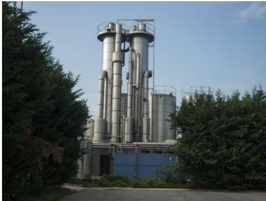
Torri di concentrazione del siero per il riutilizzo dell'acqua
