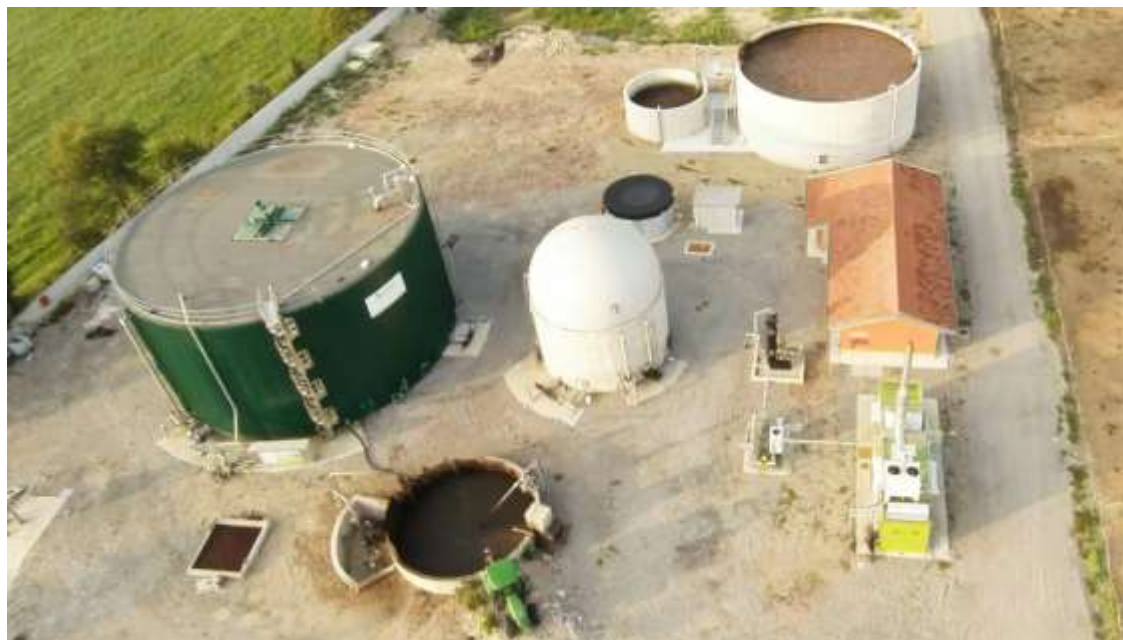
Impianto di abbattimento dei nitrati
